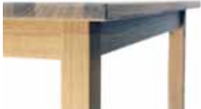
Detalje på kantprofil C og ben 1 hvor sargen er trukket 5 cm ind.
